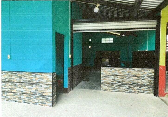
Foto1: Mejoramiento de cocina: Puerta, ventana, pila, piso, iluminación, gabinetes, mesa y azulejo.
