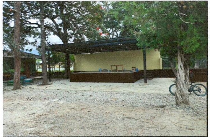
Foto 4: Mejoramiento de losa de patio.
